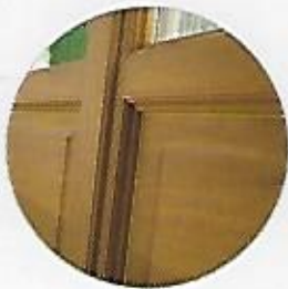
Panneau de soubassement plate-bande avec joints marron caramel
